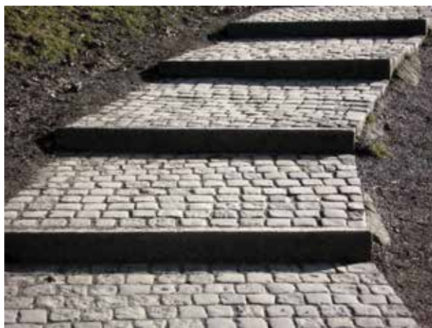
Fig 7.24 Åsnestig med sättsteg av kantsten och plansteg av gatsten
