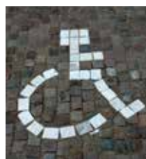
Fig 5.15 Smågatsten med olika kulör satt i objektpassat mönster.
