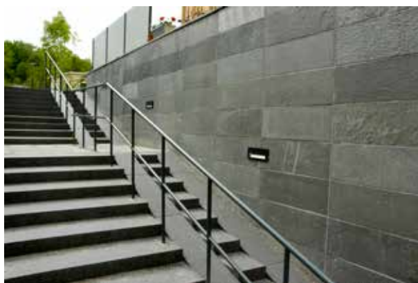
Fig 7.25 Barnvagnsramp integrerad i blockstegstrappa. Beklädnadsmur med skiffer.
