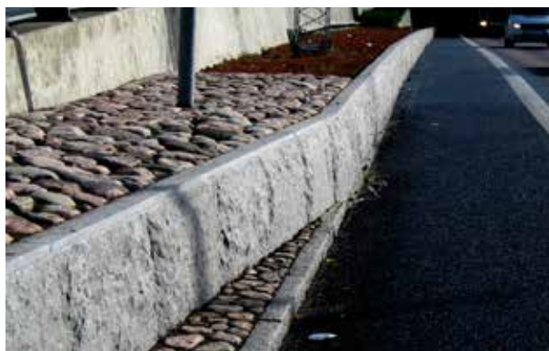
Fig 8.48 Blockstensmur av granit som stödmur och trafikbarriär
