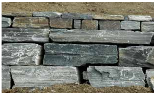
Fig 8.18 Kallmur av staplade skifferblock i kvaderförband.
