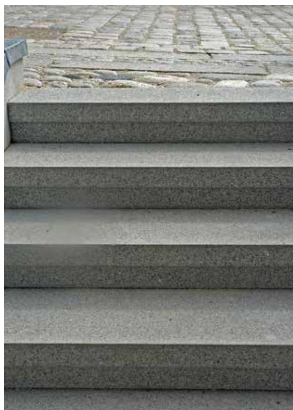
Fig 7.3 Beklädnadssteg av krysshämrad granit
