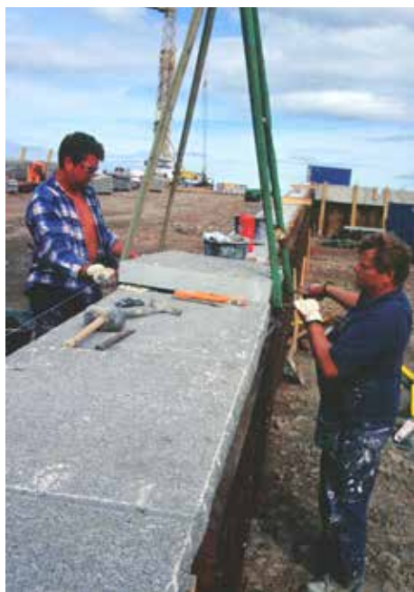
Fig 8.46 Granitavtäckning monteras
