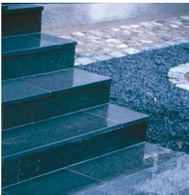
Fig 7.13 Beklädnadstrappa med steg av skiffer
