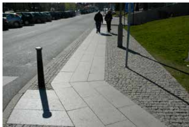
Fig 5.6 Rak stensättning med granithällar inlagda som gångyta.
