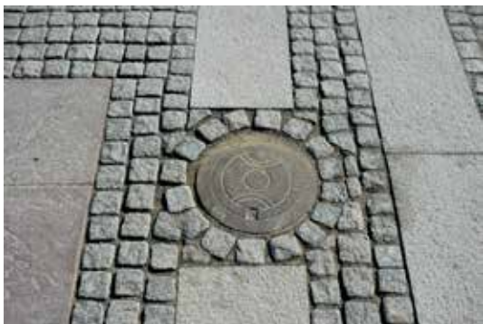
Fig 4.25 Gatsten runt brunnen ger god anpassning mot beläggningen.
