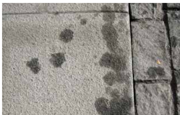
Fig 11.4 Misspdydande oljefläckar på granitramsten.
