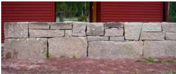
Fig 8.7 Kallmur av granitblock i rubbelförband
