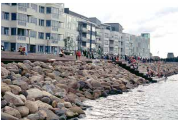
Fig 8.40 Släntbeklädnad uppbyggd av runda fältstenar, som erosionsskydd mot havet.
