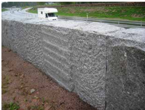
Fig 8.50 Missförstånd vid beställning från främmande land kan leda till leveranser som man inte har förväntat sig, i detta fall med mycket varierande ytbearbetning.
