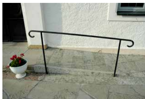
Fig 7.26 Låg ramp av kalksten för bättre tillgänglighet.
