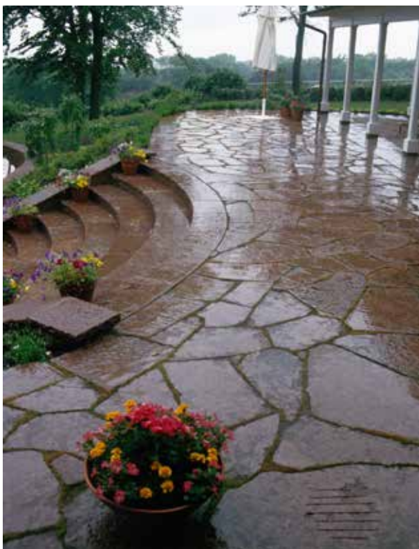
Fig 4.14 Altan med topphyvrad kalksten i oregelbundet mönster.
