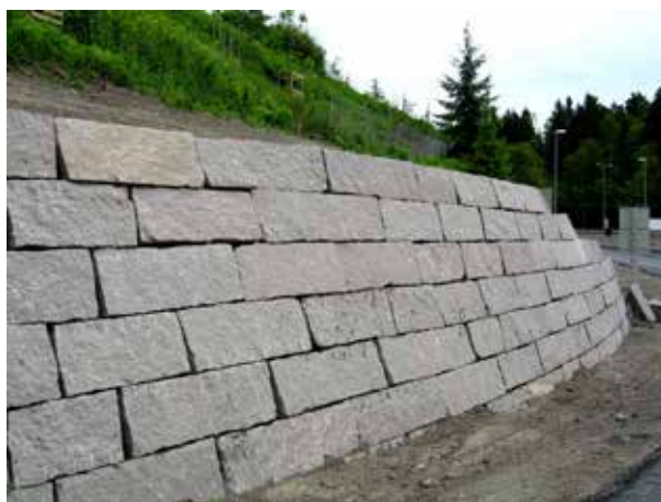
Fig 8.29 Kallmur av granitblock i vägsärning.
