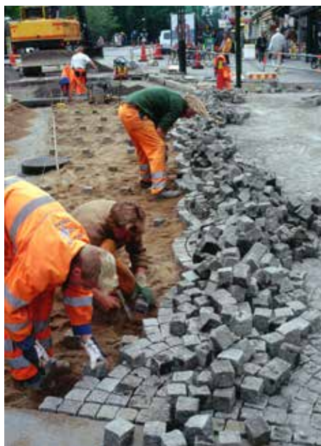
Fig 5.10 Bågsättning av smågatsten i sand
