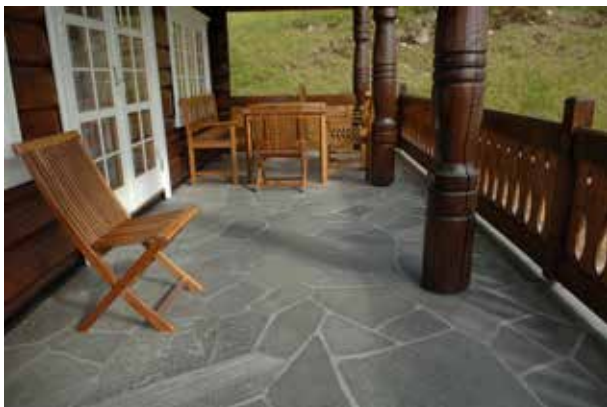
Fig 4.29 Altanbeläggning, skiffer med klovyta.
